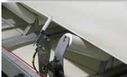
Contrôle de déport de sangle
